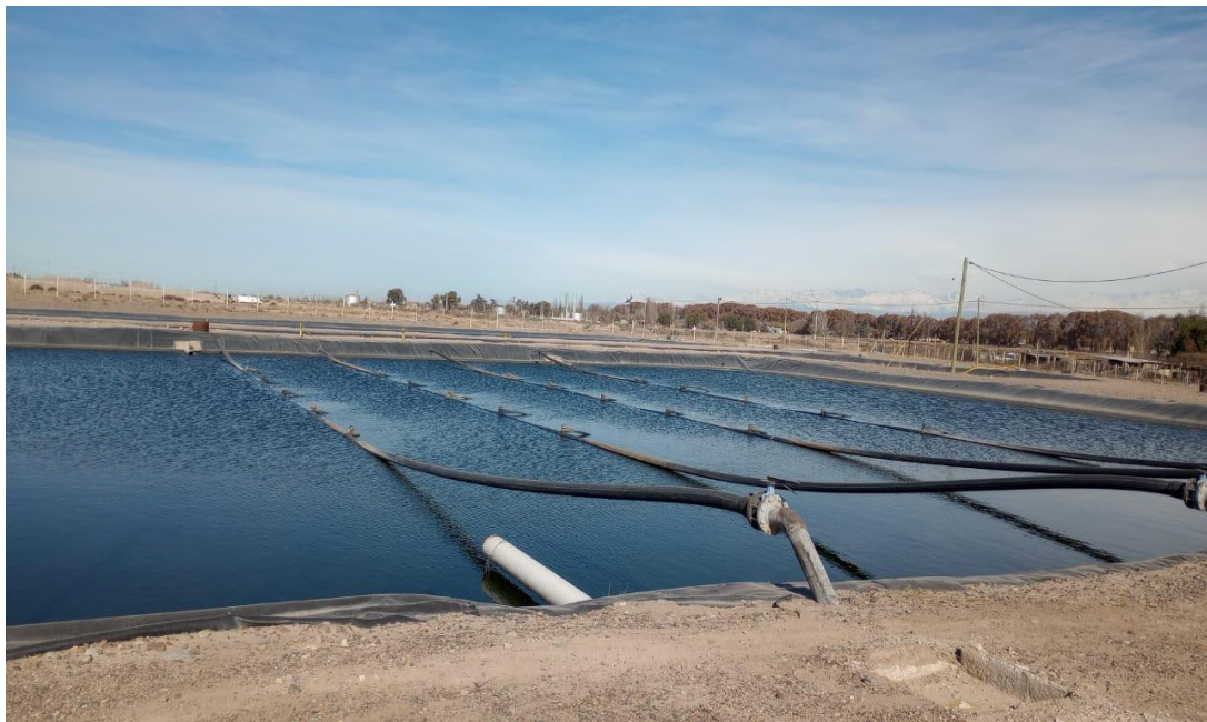
Figura 1: Laguna aireada con sopladores.
