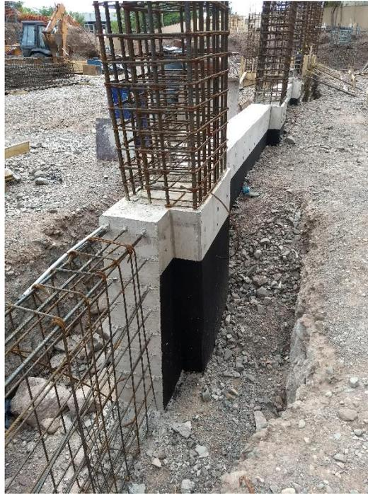
*Figura 19. Viga de fundación hormigonada.*
