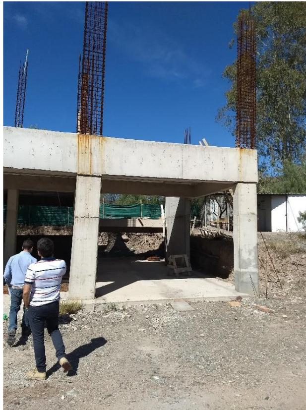
*Figura 9. Detalle de columna fuera de plomo.*
