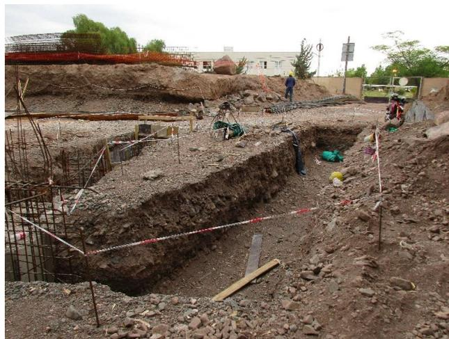
*Figura 13. Excavación para viga de fundación y pilotes.*
