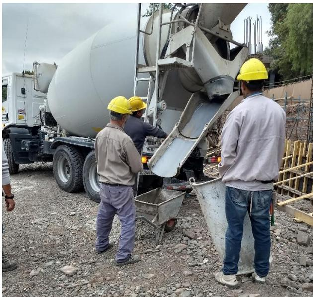
*Figura 16. Toma de muestra para realizar ensayo y probetas.*
