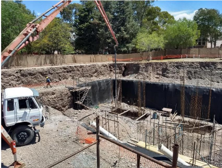
Figura 17. Hormigonado con bomba hidráulica.
