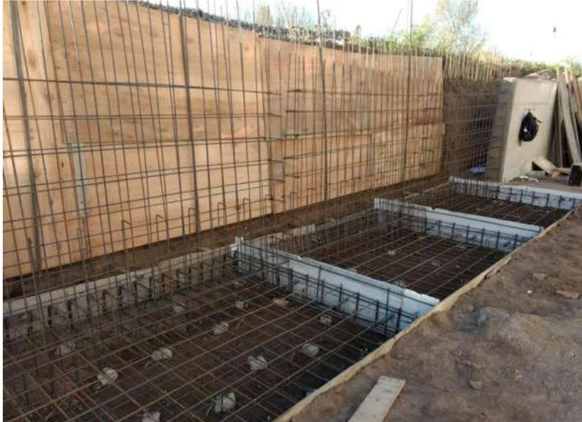
*Figura 7: Encofrado del muro de sostenimiento*
