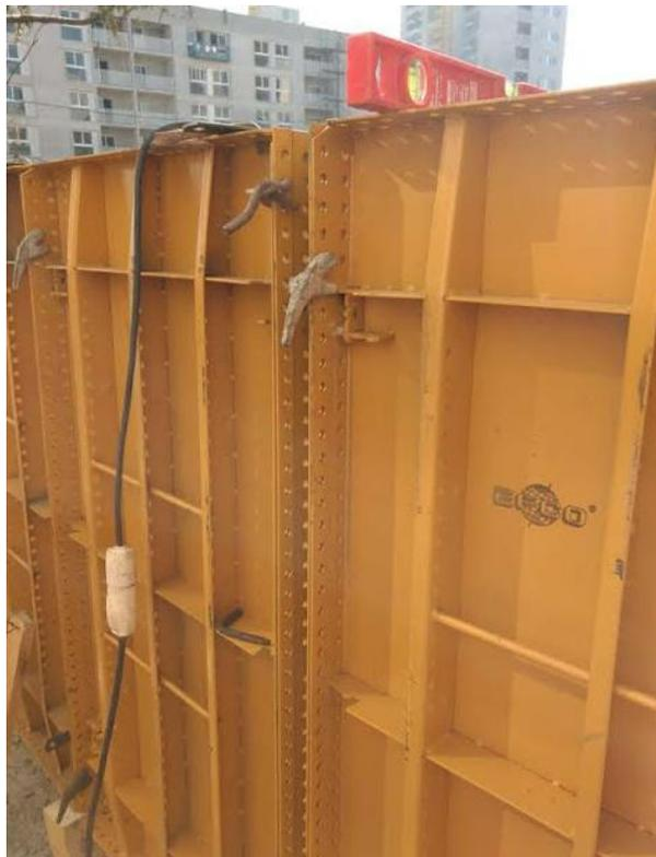
*Figura 12: Encofrado metálico*
