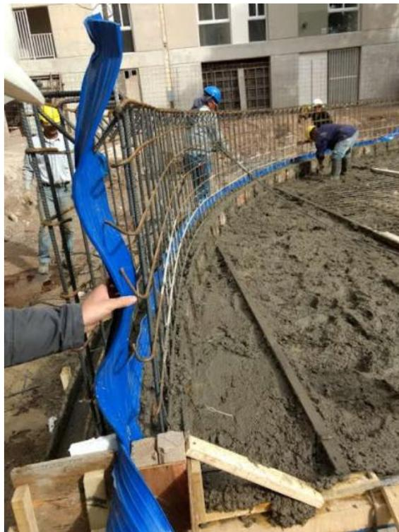
*Figuras 10: Uso de la banda (water stop)*
