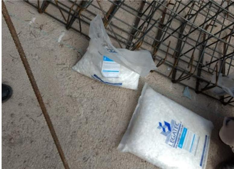
*Figura 11: Fibras de polipropileno*
