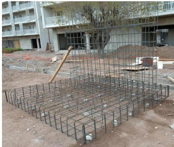
*Figuras 5 y 6: Detalle de armado del muro de sostenimiento.*
