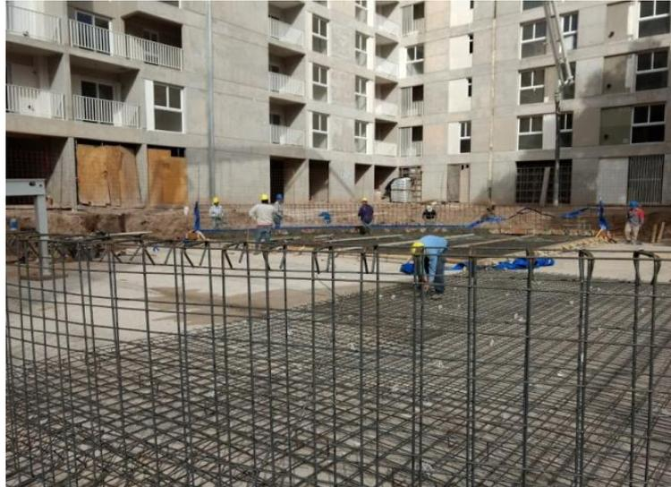
*Figura 9: Armado del reservorio*
