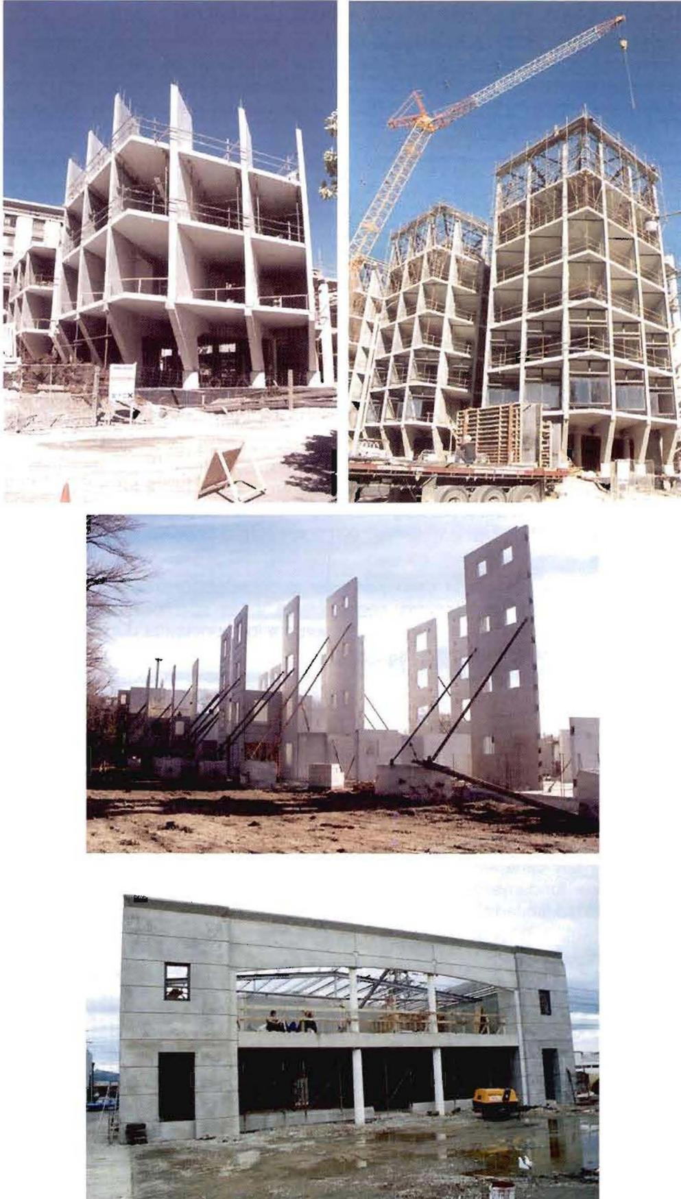
Figura 1 - Vistas de construcciones con paneles prefabricados
