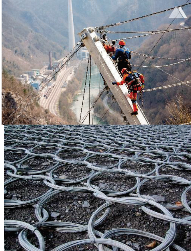
Imagen 39: Red de anillos y postes barreras dinámicas tipo RXE.
