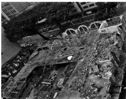
Demolición del Edificio Gonzalo Mejía para la construcción del Edificio Coltejer. Digar, 1968.
