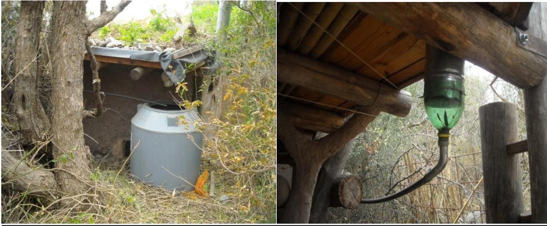
*Foto N°14. Tacho cosechador de agua del techo vivo y sistema de embudo recolector y manguera del techo de la cocina comunitaria. Fuente propia.*
