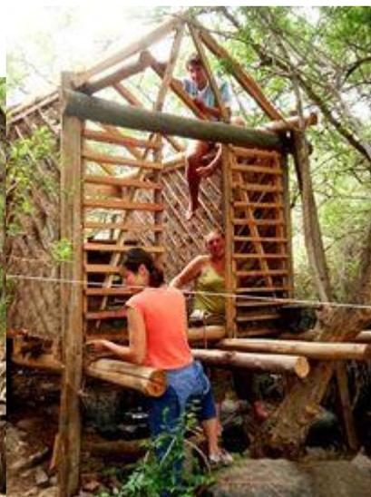
Foto °21. Proceso de construcción en Quincha de la casita del árbol. Fuente: El Jardín de los Presentes.
