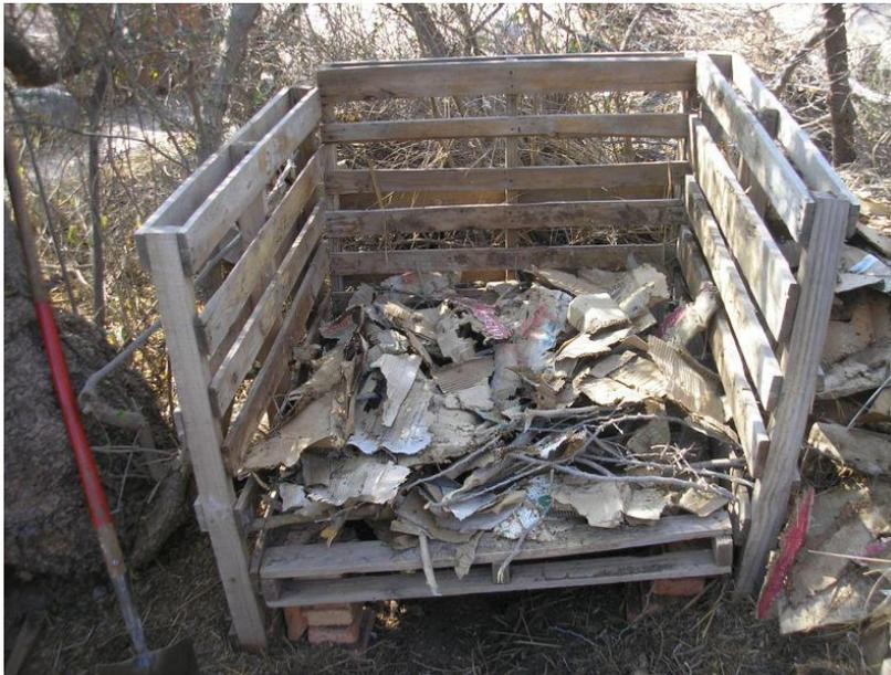
*Foto N°28. Armado de la compostera para materia fecal. Fuente propia.*
