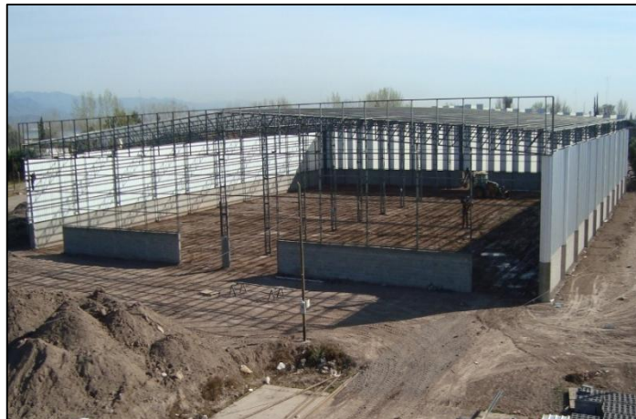
Fig. N° 5 – Estructura de nave industrial, Zakalik.
