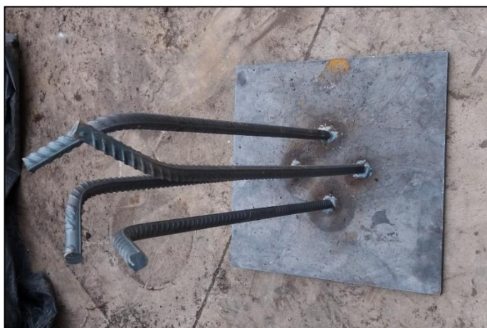
Fig. N° 19 – Placa de anclaje con hierros.
