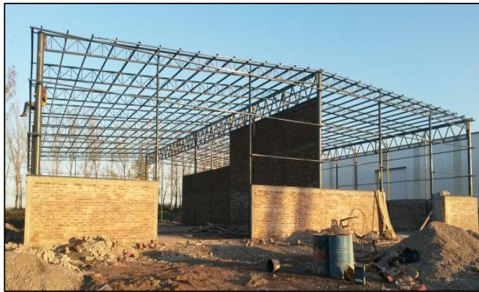
Fig. N° 8 – Estructura de nave industrial 1, Pujol.
