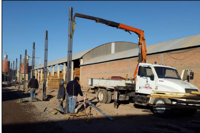
Fig. N° 4 – Montaje de columnas de estructura, Valerio Oliva.
