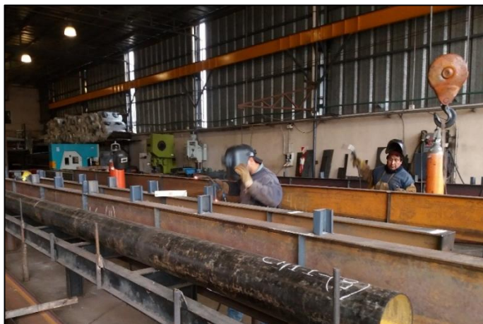
Fig. N° 16 – Elaboración de vigas con porta-correas y rigidizadores.
