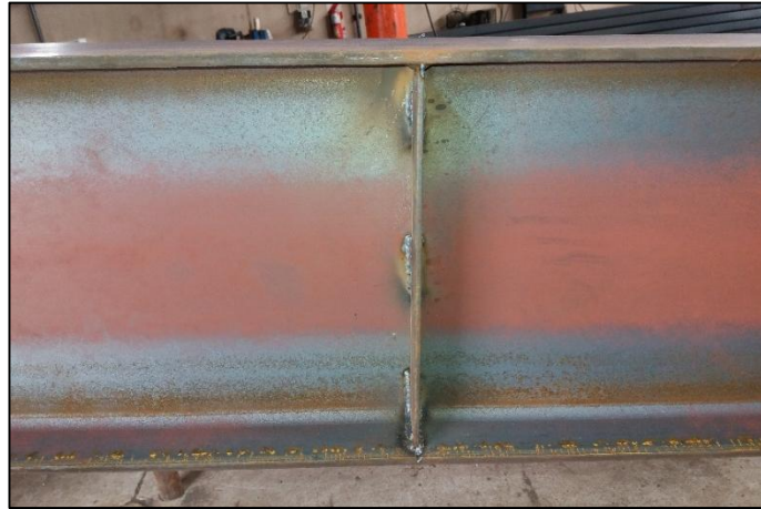
Fig. N° 20 – Control de soldaduras.
