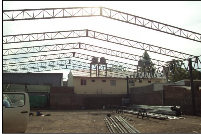
Fig. N° 2 – Montaje de estructura de nave industrial, Yacopini.
