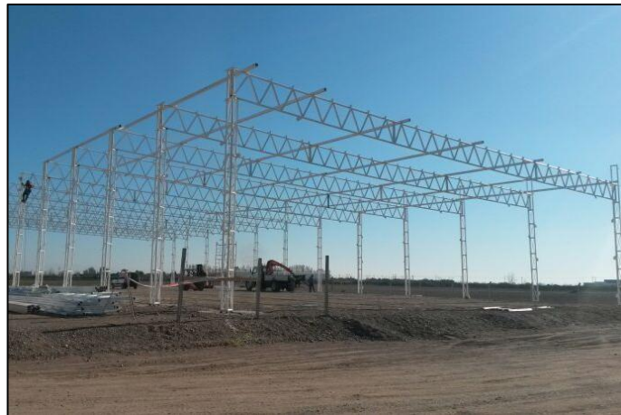
Fig. N° 3 – Estructura de nave industrial, Giuliani.
