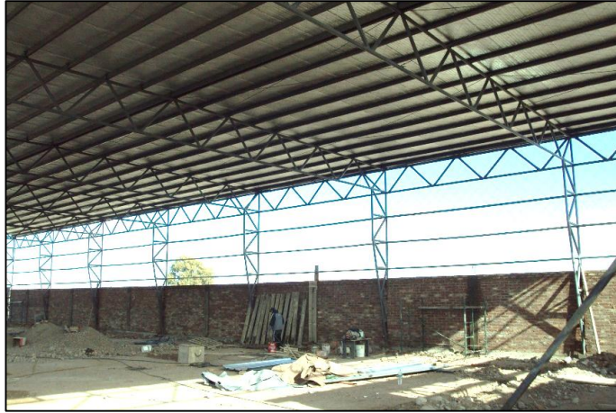
Fig. N° 7 – Estructura y cubierta de techo, Oeste Bombas.
