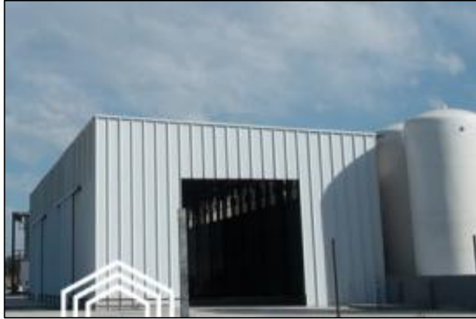
Fig. N° 10 – Nave industrial terminada, Bio Agil.
