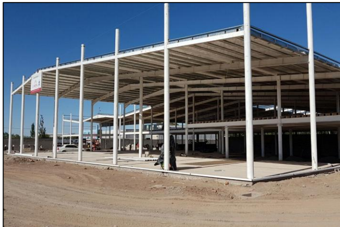
Fig. N° 12 – Nave industrial en construcción, Volkswagen.
