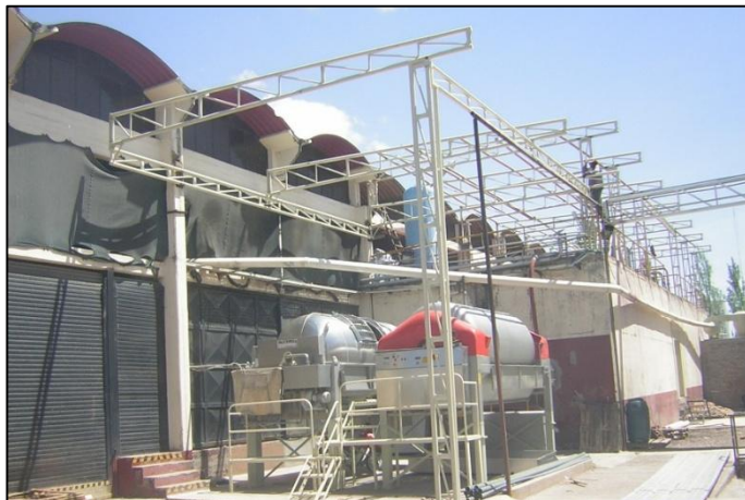
Fig. N° 6 – Estructura de nave industrial, Viniterra.
