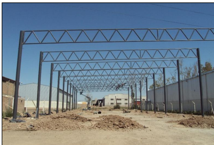
Fig. N° 9 – Estructura de nave industrial 2, Pujol.
