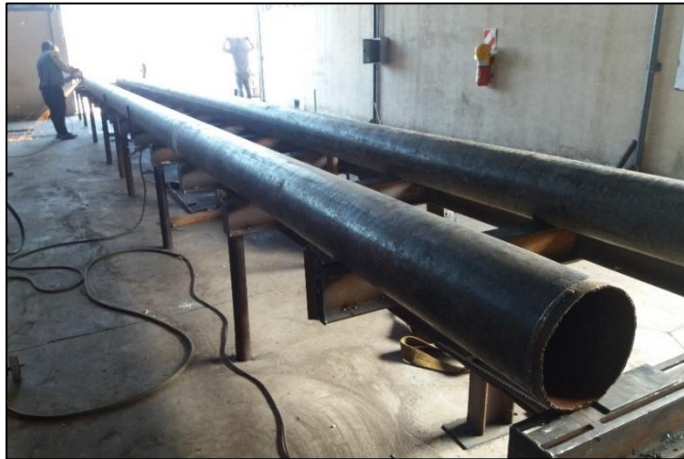
Fig. N° 15 – Fabricación de columnas.
