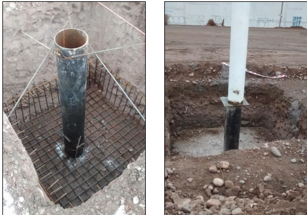
Fig. N° 23 – Bases, con armaduras y fustes.
